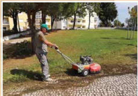
Deservagem de calçada
