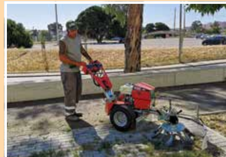
Deservagem de pavimento
