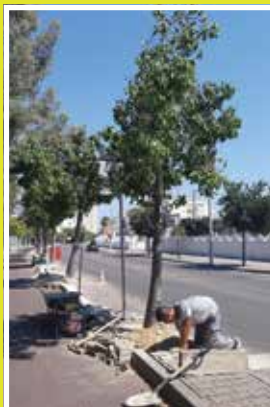
Alargamento das caldeiras das árvores
