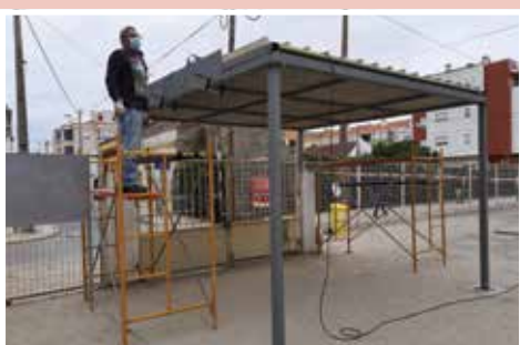
Colocação de telheiros e rampas de acessibilidade
