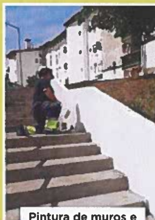
Pintura de muros e muretes
