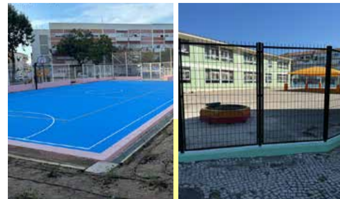
REQUALIFICAÇÃO DO POLIDESPORTIVO E JARDIM DA ESCOLA BÁSICA N.º 5 E RECUPERAÇÃO DO GRADEAMENTO DA ESCOLA BÁSICA HENRIQUE GALVÃO (ANTIGA N.º 7)
